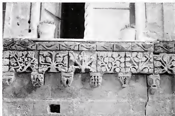
Fig. 3. - PALERMO: Sottofascia di una finestra in una casa normanna.
